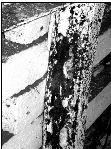
Rys. 2. Perforacja łuku ociosowego
