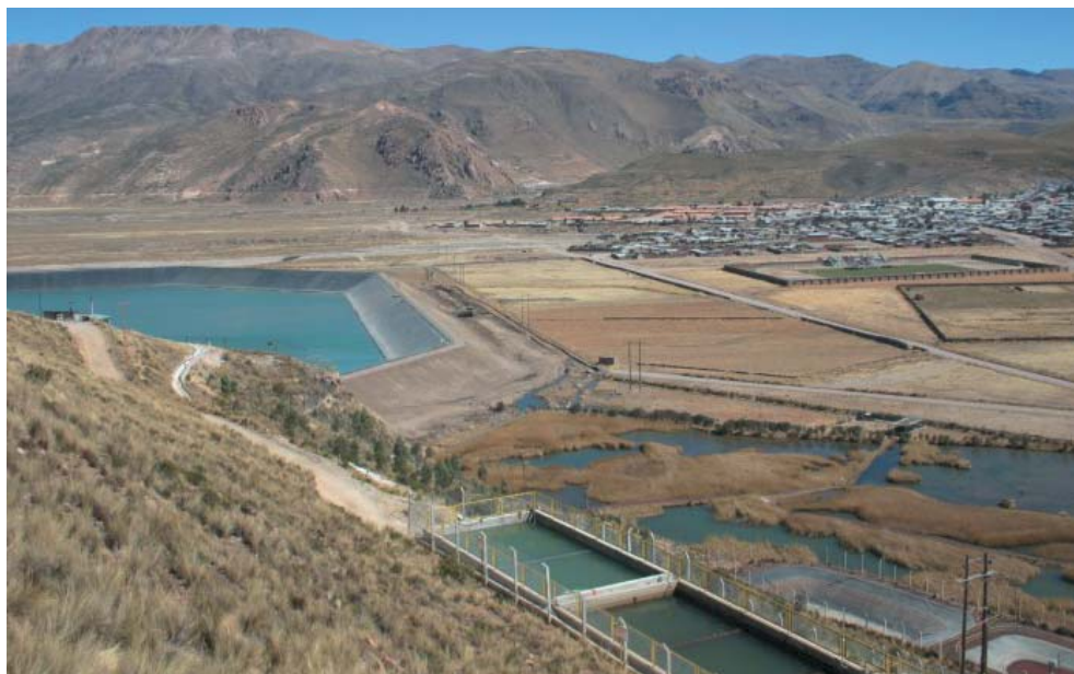
Fig. 2. Kopalnia Orcopampa – osadnik i park ekologiczny przy zakładzie przeróbczym, w tle miasteczko
