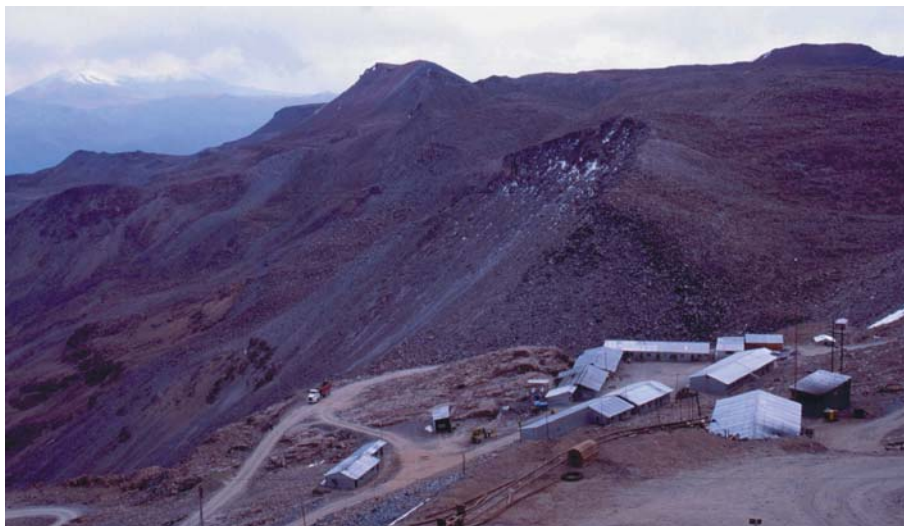
Fig. 5. Budynki techniczne kopalni Shila
