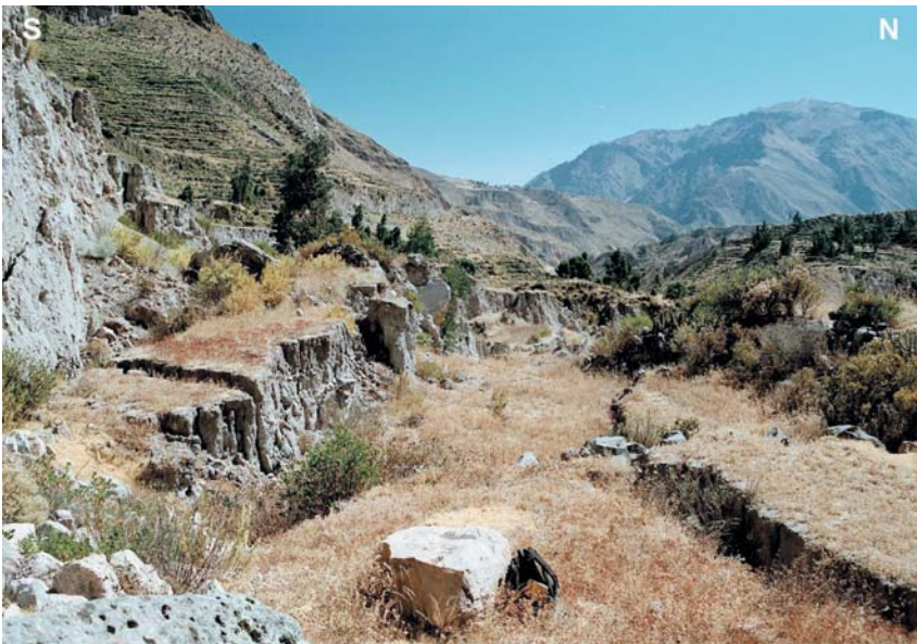
Fig. 15. Rów tektoniczny rozwinięty w czwartorzędowych koluwiach w Maca (domena 5)
