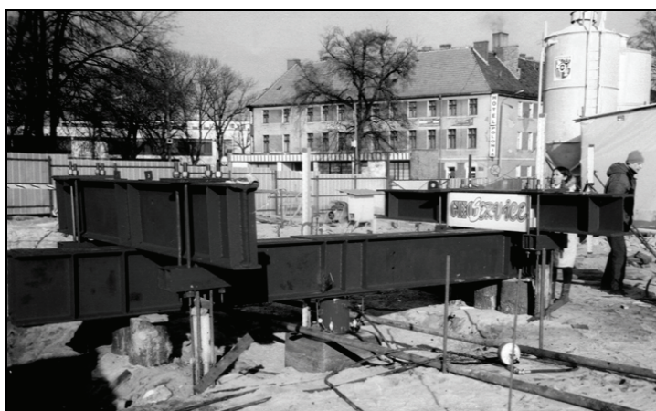
Rys. 1. Stanowisko do badań nośności pali jet-grouting
