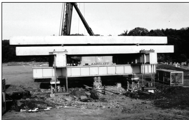
Rys. 2. Stanowisko do badań nośności pali prefabrykowanych. Widoczny balast z pali
