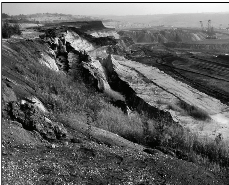
Rys. 4. Turów — osuwisko z 2006 r. Zerwa na poz.+150 z przesunięciem skrzydła wiszącego uskoku o asekwentnym upadzie
