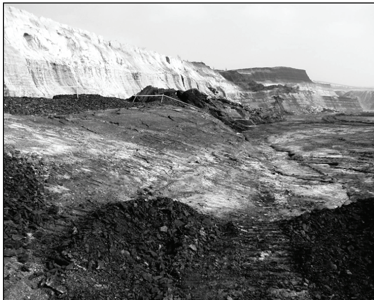
Rys. 5. Turów — osuwisko z 2006 r., wypiętrzenie i zaciśnięcie rowu na poz. +110
