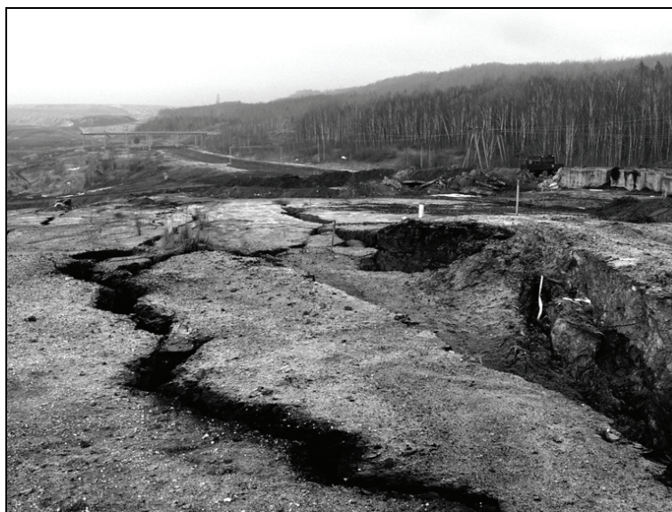
Rys. 7. Turów — osuwisko — deformacje na poz. +180 (stan na 2.01.2008 r.)
