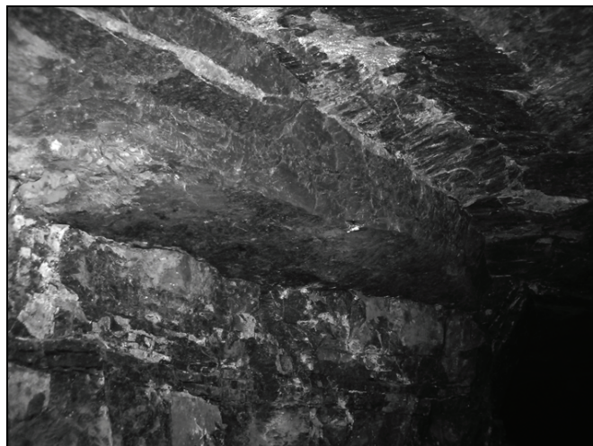
Rys. 9. Ślady subhoryzontalnych przesunięć pakietów ławic dolomitów — pole G-7/5 oddziału G-7 kopalni „Rudna”
