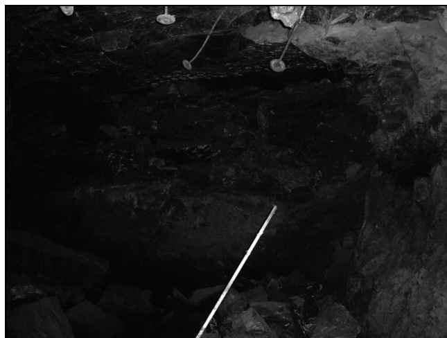
Rys. 6. Obwał stropowego dolomitu smugowanego w rejonie krzyżówki pasa P-14 z komorą K-1b pola eksploatacyjnego G-6/7 oddziału G-26 kopalni „Rudna”
