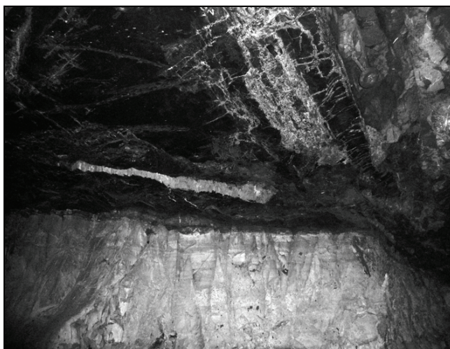
Rys. 5. Powierzchnie kliważu foliacyjnego i system stromych spękań tensyjnych o biegu NW–SE w stropowym dolomicie smugowanym oraz porwaki piaskowca w obrębie łupków miedzionośnych w rejonie skrzyżowania pasa P-19 z komorą K-1c pola eksploatacyjnego G-6/7 oddziału G-26 kopalni „Rudna”
