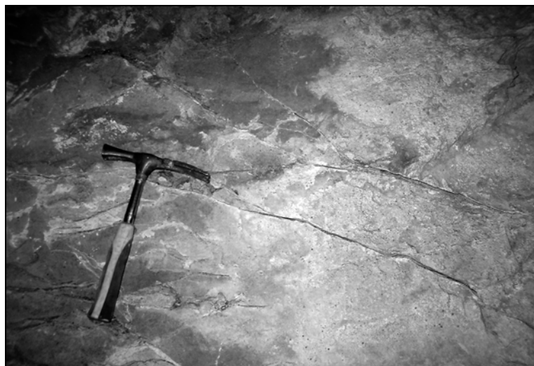
Rys. 8. Ślady spękań w piaskowcu wypełnione siarczanami
