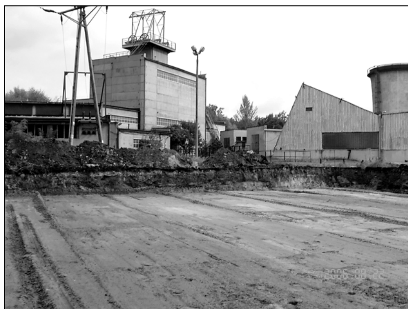
Rys. 4. Widok wykopu w miejscu wykonywanego zabezpieczenia geotechnicznego
