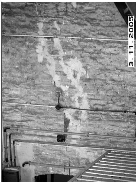
Rys. 5. Ściana wieży z widocznymi miejscami iniekcji i klejenia
