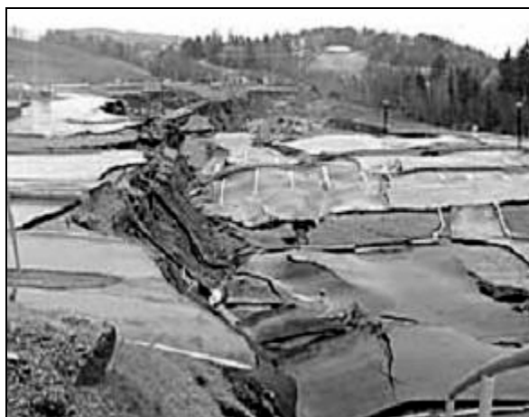
Rys. 11. Osuwisko w rejonie Stjordal — Norwegia
