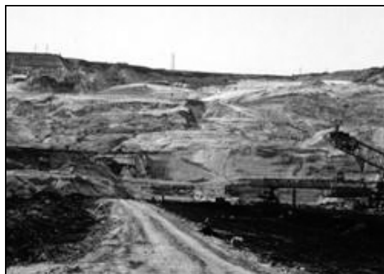
Rys. 16. Osuwisko 20S na południowym zboczu KWB „Bełchatów”
