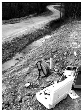
Rys. 2. Monitoring przemieszczeń wglębnych i ciśnienia porowego wód gruntowych
