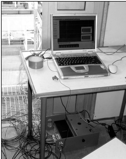
Rys. 3. Widok rejestratora z analizatorem drgań
