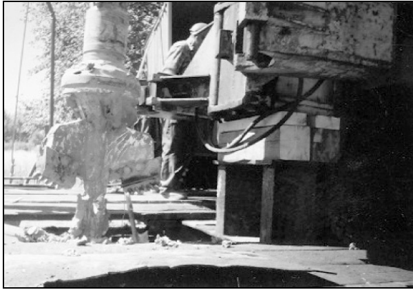
Rys. 5. Wycofany świder \varnothing 670L po wierceniu otworu G1 w miejscowości Dobrowoda [6]
