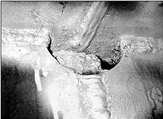
Rys. 3. Wadliwie wykonane spoiny dźwigara koparki KWK-1500s
