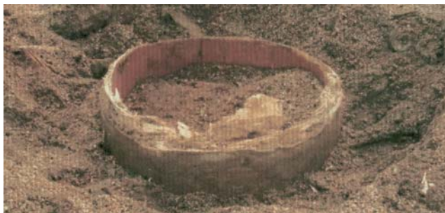
Rys. 3. Widok uciętej kolumny rur okładzinowych
