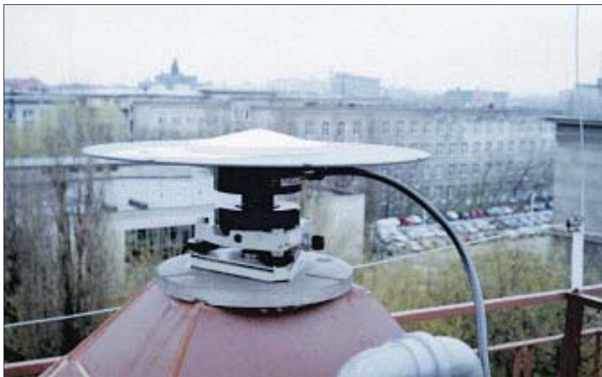
Rys. 1. Antena ASH701008.01B na dachu budynku Wydziału Geodezji Górniczej i Inżynierii Środowiska AGH
