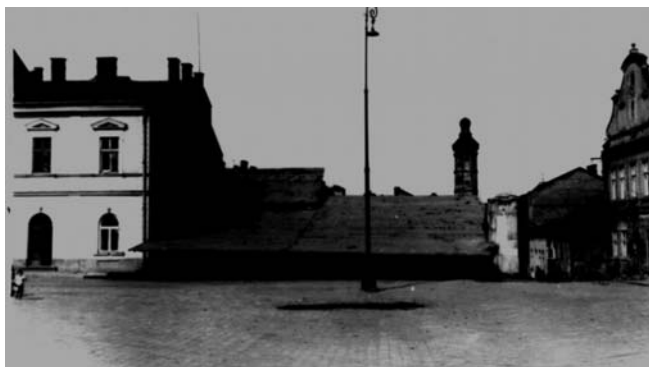
Rys. 2. Zadaszone prowizorycznie miejsce po zapadniętych budynkach Rynek 19 i 20 (obecnie nr 17 i 18) Źródło: zdjęcie z Archiwum Muzeum w Jarosławiu
