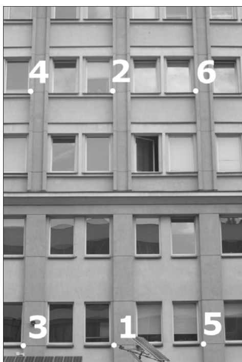
Rys. 3. Pole testowe – sześć punktów kontrolnych obranych na elewacji budynku C4 (AGH)
