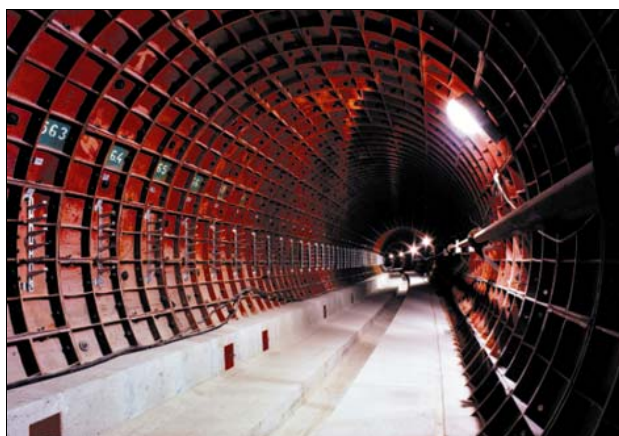
Rys. 3. Metro Warszawskie — tunel w obudowie tubingowej
