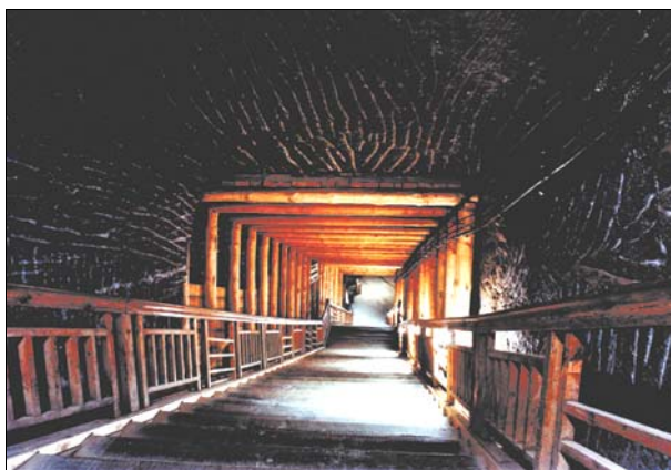
Rys. 1. Wieliczka — prace rekonstrukcyjne
