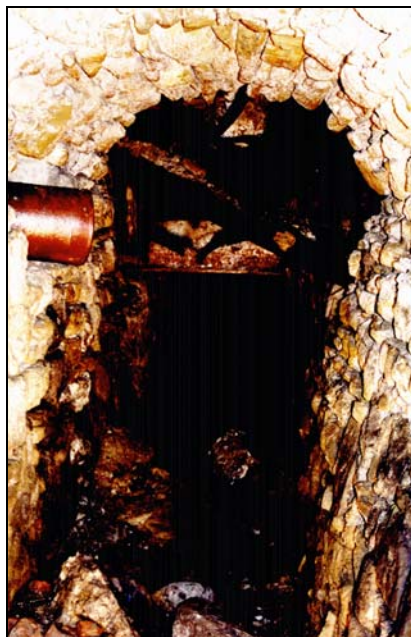
Rys. 4. Zdjęcie typowego odcinka kolektora kanalizacyjnego
