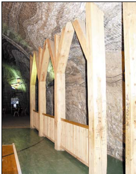
Rys. 3. Konstrukcja wsporcza — zabezpieczająca północno-zachodnią część ociosu komory „Ważyn”
