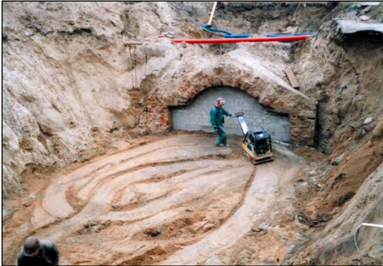
Rys. 6. Stabilizacja zasypu po zamowaniu końca tunelu
