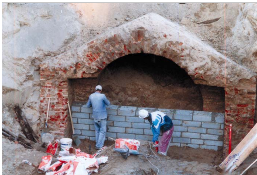
Rys. 5. Zabezpieczanie końca tunelu ścianą poprzeczną
