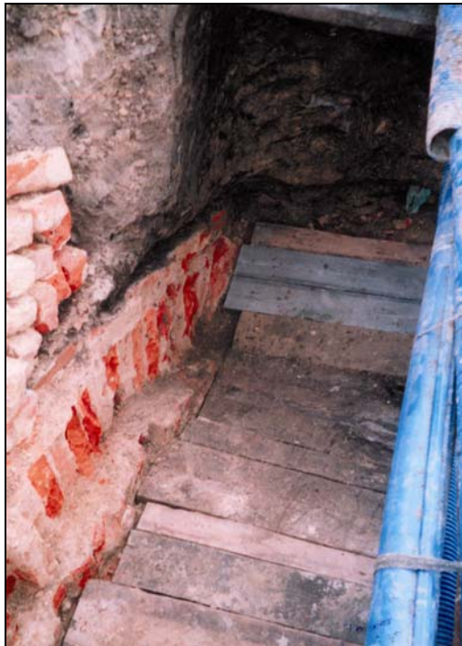
Rys. 7. Rozkuty strop poterny przygotowany do odtworzenia
