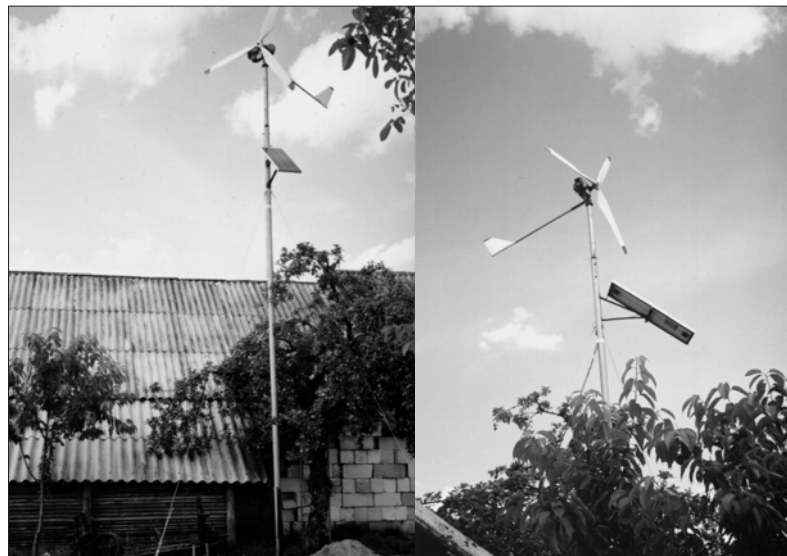
Rys. 13. Elektrownia słoneczno-wiatrowa
