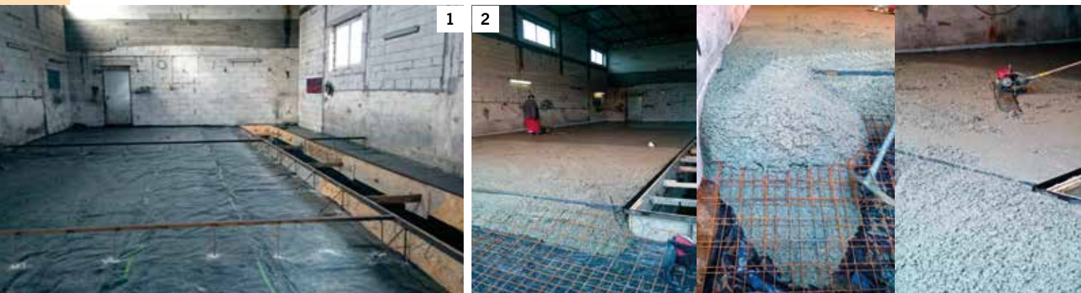
Fot. 1. Wnętrze budynku, w którym prowadzono badania. Powierzchnia planowanej posadzki została podzielona na pola testowe Fot. 2. Proces układania mieszanki betonowej
