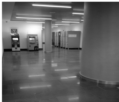
Rysunek 6. Swobodne dojście do skrytek bagażowych – brak zabezpieczeń, Bydgoszcz Główna (2016 r.)
