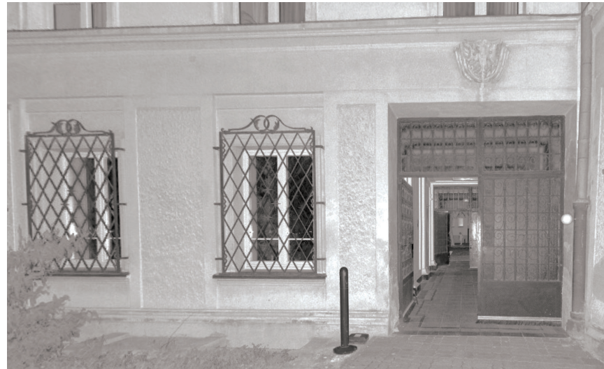
Rys. 13. Widok skanu 3D fragmentu elewacji badanego budynku
