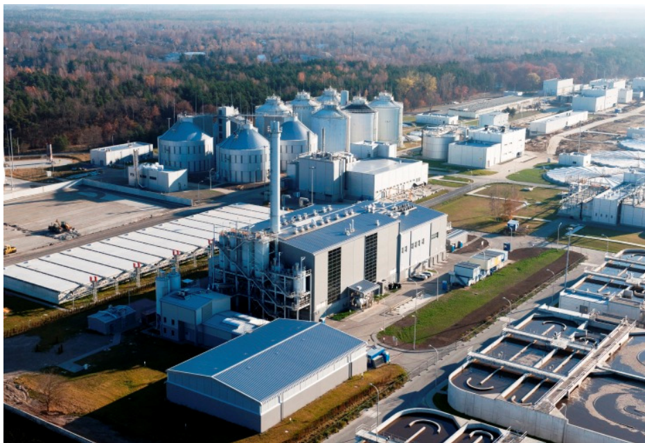
Rys. 12. STUOŚ w Oczyszczalni Ścieków „Czajka” w Warszawie [25]
