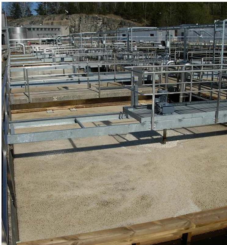
Rys. 11. Oczyszczalnia Himmerfjärden - Nitrytacja/Anammox - reaktor jednostopniowy z bloką biologiczną [24]
