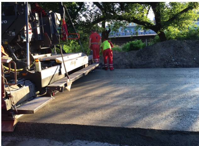
Rys. 1. Wykonywanie nawierzchni w technologii betonu wałowanego, ul. Makowska, Warszawa, czerwiec 2018 r.
