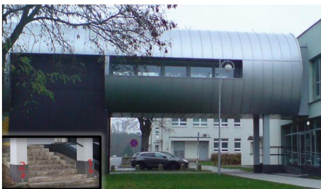
Rys. 2. Widok obiektu nr 1
