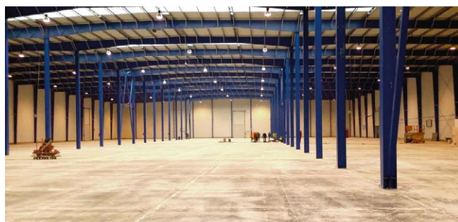
Rys. 4. Widok hali przemysłowej
