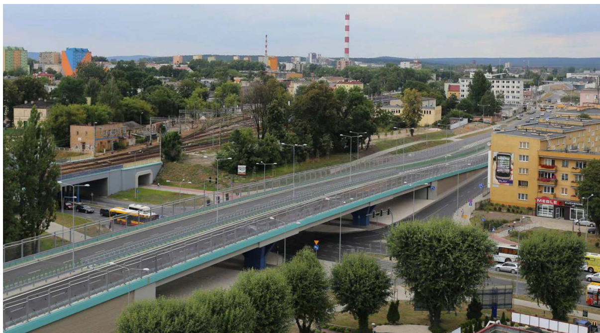
Fot. 2. Widok na estakady nad skrzyżowaniem ulic: Żelazna – Żytnia – Grunwaldzka – Armii Krajowej
