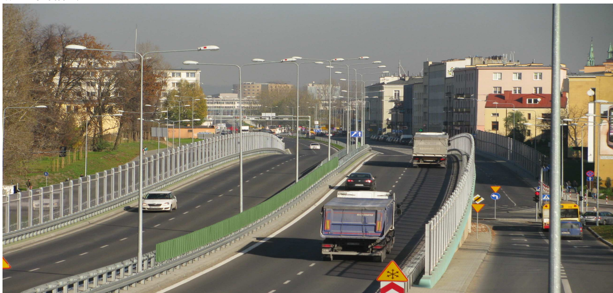
Fot. 1. Węzeł Żytnia po zakończeniu inwestycji
