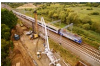
Pale FRANKI NG pod obiektami S5 Poznań - Wrocław na odcinku Korzeńsko (bez węzła) - węzeł Widawa Wrocław, zadanie 1
