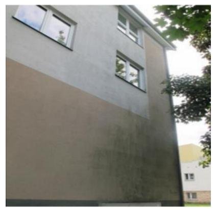
Phot. 1. View of the north-west facade of the building of the Institute of Environmental Engineering at the University of Zielona Góra, covered with the biofîlm [Lechów 2014] Fot. 1. Widok na zachodnio-północną elewację budynku Instytutu Inżynierii Środowiska Uniwersytetu Zielonogórskiego z nalotem biologicznym [Lechów 2014]
