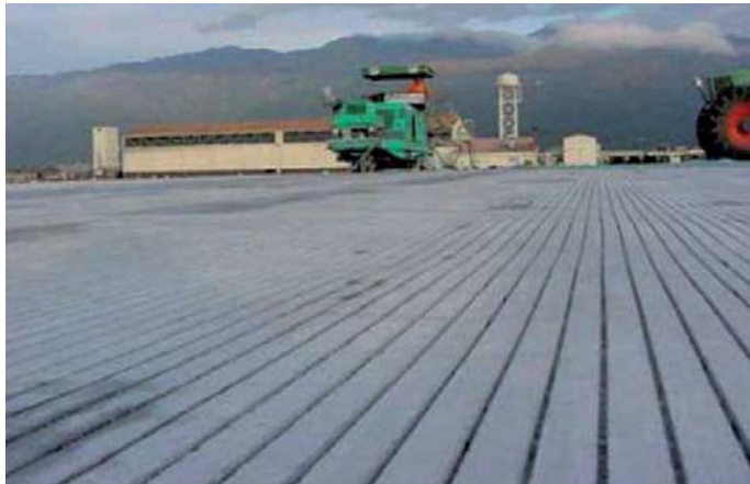
Fot. 2. Tekstura na odcinku nawierzchni uzyskana metodą typu grooving [2]
