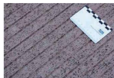
Fot. 8. Odcinek próbny na drodze A12 – zdjęcia trzech typów tekstury nawierzchni na przykładzie Betonu nr 3: z lewej – tekstura nr 1, w środku – tekstura nr 2, z prawej – tekstura nr 3 [5 i 6]
