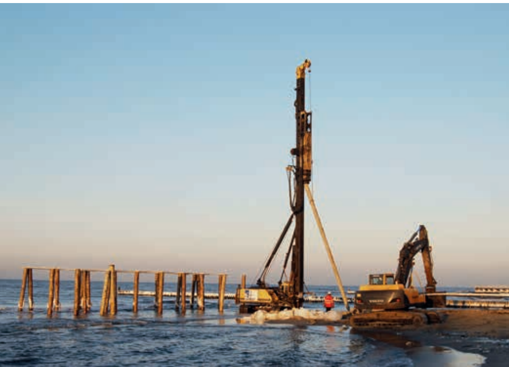
Wykonywanie pali w Ustroniu Morskim, fot. Aarsleff Sp. z o.o.
