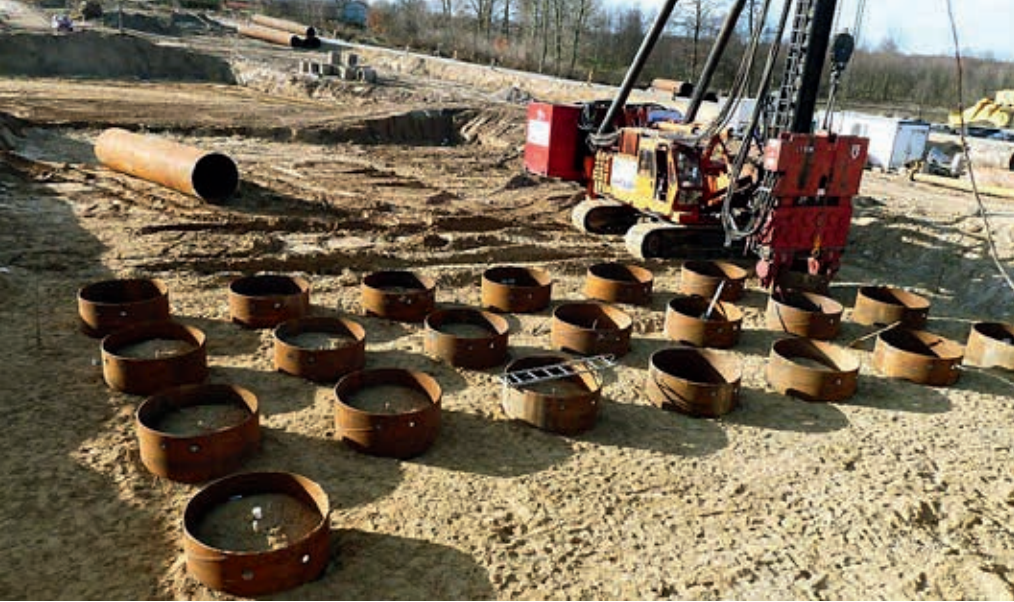
Pale stalowe rurowe wibrowane, fot. Aarsleff Sp. z o.o.
