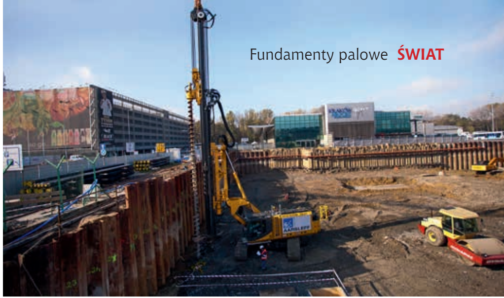
Wykonywanie pali CFA w porcie lotniczym Kraków Airport w Balicach, fot. Aarsleff Sp. z o.o.
