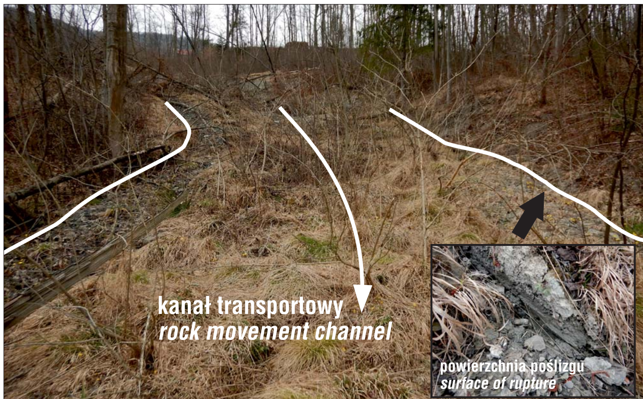
Ryc. 11. Kanał transportowy z rumoszem skalnym Fig. 11. Rock movement channel
