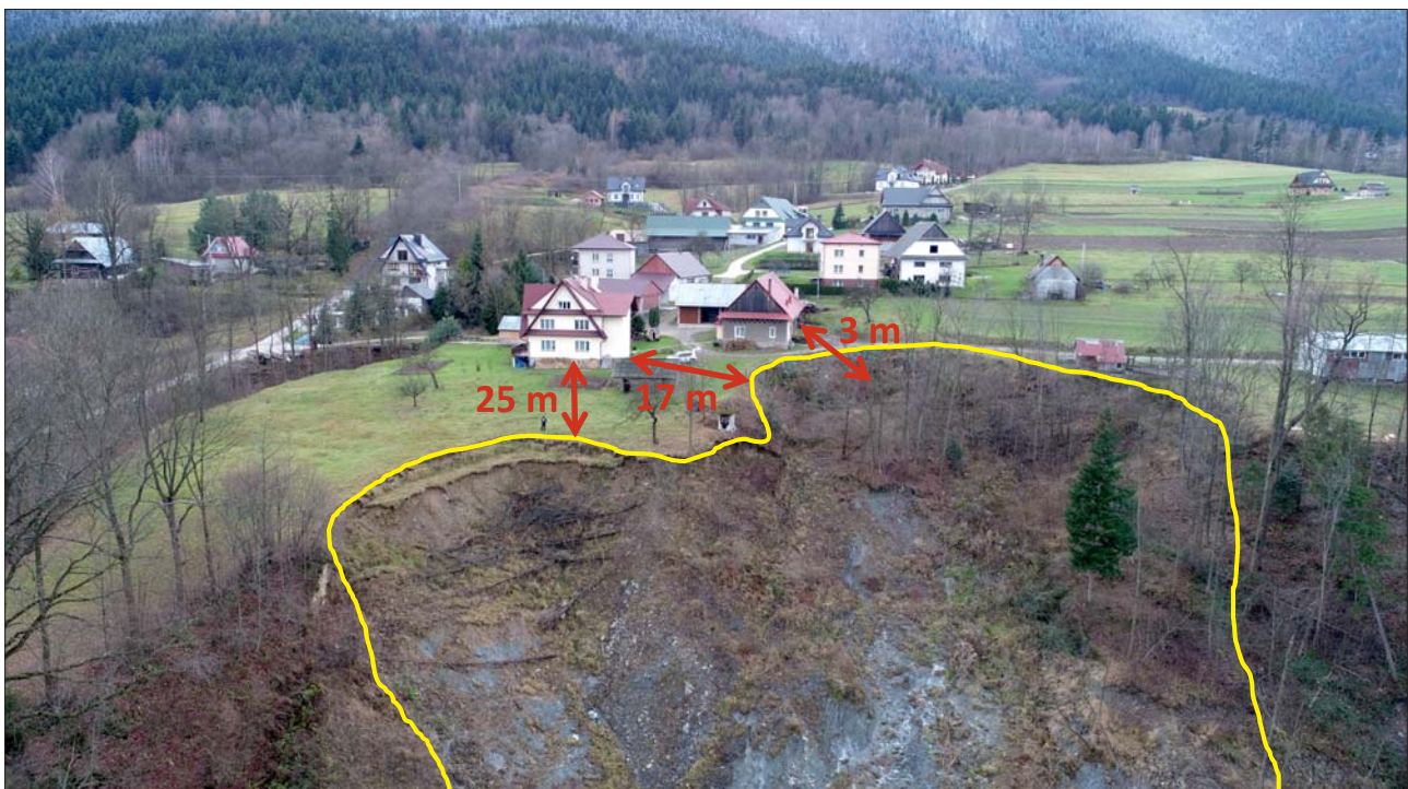
Ryc. 2. Skarpa główna i zagrożone budynki na osuwisku w Kasince Małej Fig. 2. Main scarp and endangered buildings on the Kasinka Mała landslide
