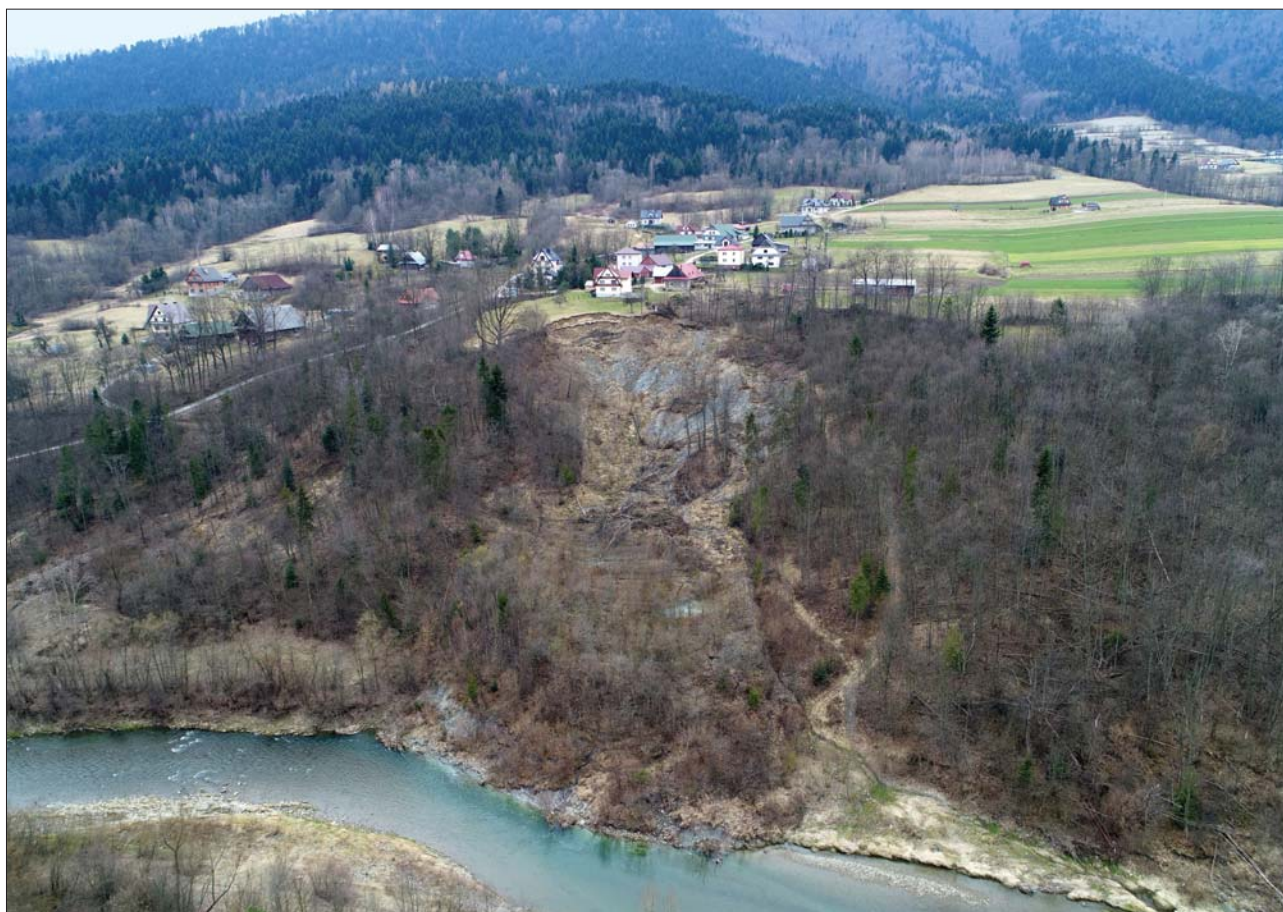
Widok z pułapu drona na aktywne osuwisko w Kasince Małej. Fot. K. Karwacki Bird's-eye view UAV photography of an active landslide in Kasinka Mała village. Photo by K. Karwacki
