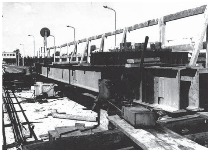
Fot. 9. Montaż konstrukcji odciążającej podczas remontu uszkodzonego przęsła mostu na Zalewie Bugu [2]
