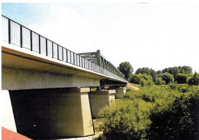
Fot. 15. Most przez Bug w Zosinie, rok budowy 1952–1955 [2]
