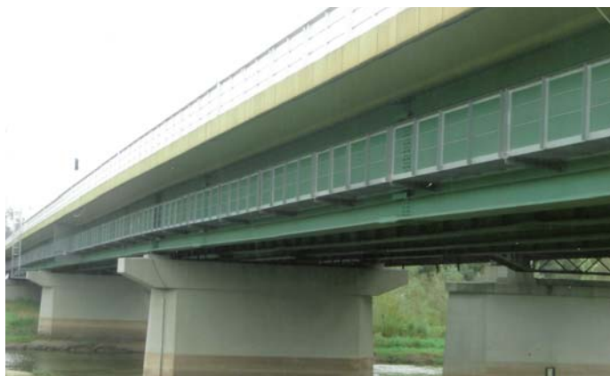
Fot. 18. Drugi most na Bugu w Dorohusku rok budowy 2002–2003 [2]
