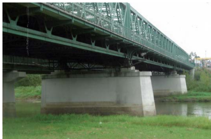
Fot. 17. Most przez Bug w Dorohusku, rok budowy 1953–1955 [2]
