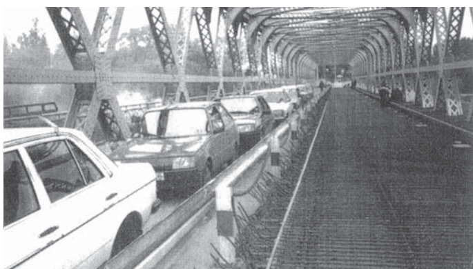
Fot. 16. Prace remontowe na pomoście mostu w Zosinie [4]
