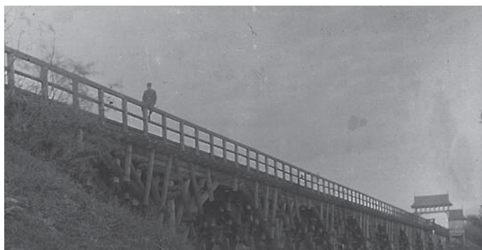
Fot. 12. Widok na most oraz bramę wjazdową na drewnianym moście w Zosinie [5]
