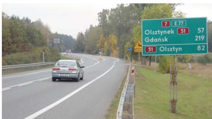
Fot. 1 i 2. Odcinek DK 7 Mława–Peplówek po 12 latach eksploatacji
