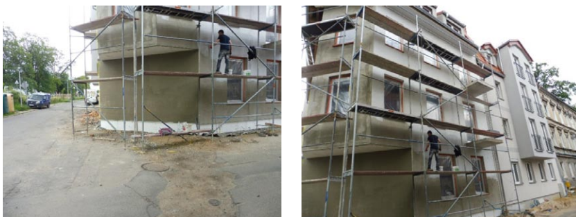
Rys. 6, 7. Widok ogólny posadowionego rusztowania
