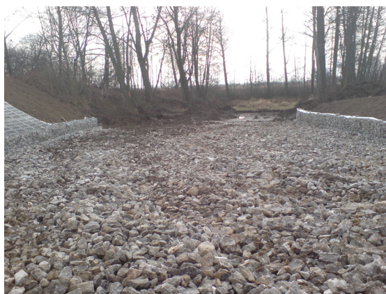
Rys. 2. Ciek pokazany na rys. 1 po wykonaniu zabudowy koryta kruszywem, gabionami i elementami betonowymi (fot. A. Dąbal).
