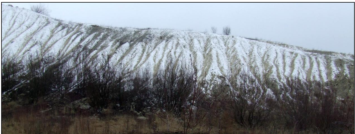
Fot. 5. Żłobiny powstałe na skutek erozji deszczowej na południowo-zachodnim stoku hałdy w kamieniołomie Lipówka w Rudnikach.
