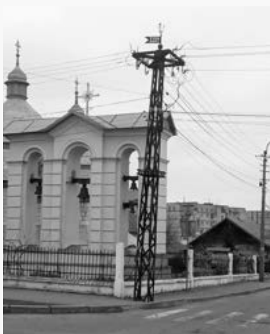
Rys. 14. S up linii przemiennego napięcia 220 V na ul. Lwowskiej w Żó kwi (zdjęcie Romana Skulskiego)
