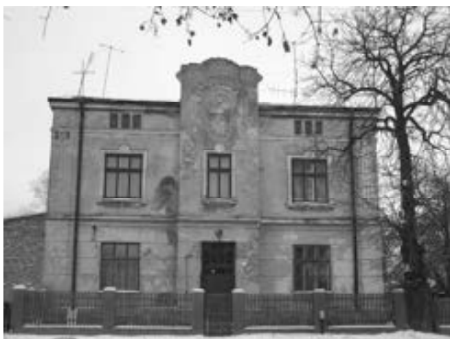
Rys. 1. Budynek byłej elektrowni miejskiej (zdjęcie Andrija Symonenka)
