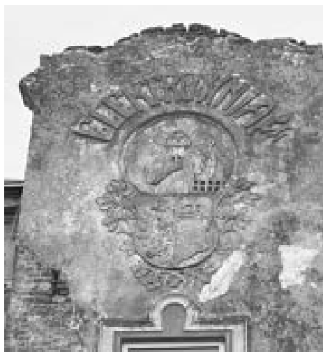
Rys. 2. Fragment elewacji byłej elektrowni miejskiej (zdjęcie Romana Skulskiego)
