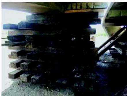
Fot. 16. Podparcie przęsła na kaszycy z podkładów kolejowych
