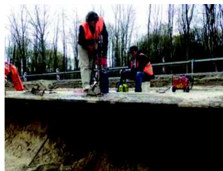
Fot. 10. Przygotowywanie otworów na przepuszczenie zawiesi
