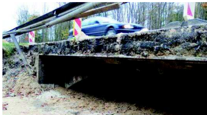
Fot. 2. Most po częściowym odstąpieniu
