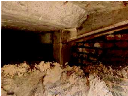
Fot. 6. Widok na ceglana ścianę zapleczną od strony przęsła (a) oraz ceglane skrzydła mostu (b)
