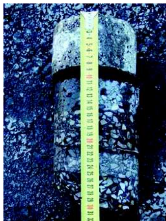
Fot. 5. Widok na nawierzchnie bitumiczne na moście (a) oraz odwiert rdzeniowy przez warstwę nawierzchni (b)
