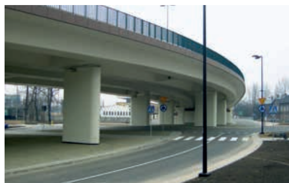
Ryc. 16. Wiadukt w ciągu ul. Wita Stwosza w Krakowie, fot. P. Gwoździwicz
