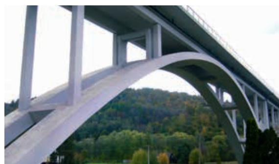
Ryc. 17. Most w ciągu S69 w Miłowce, fot. P. Gwoździwicz
