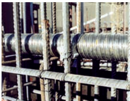
Ryc. 3. Osłonki kabli w szalunku, fot. P. Gwoździwicz
