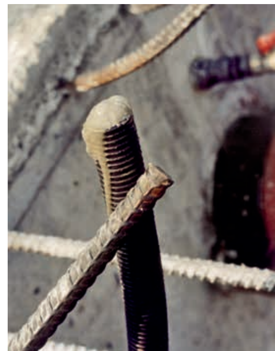
Ryc. 11. Widok rurki odpowietrzającej kanał kablowy na końcu konstrukcji, wypływający spieniony zaczyn cementowy, fot. P. Gwoździewicz
