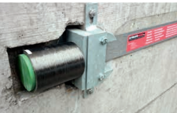
Ryc. 9. Zakotwienie taśmy sprężającej nowej generacji, fot. dzięki uprzejmości Sika oraz StressHead
