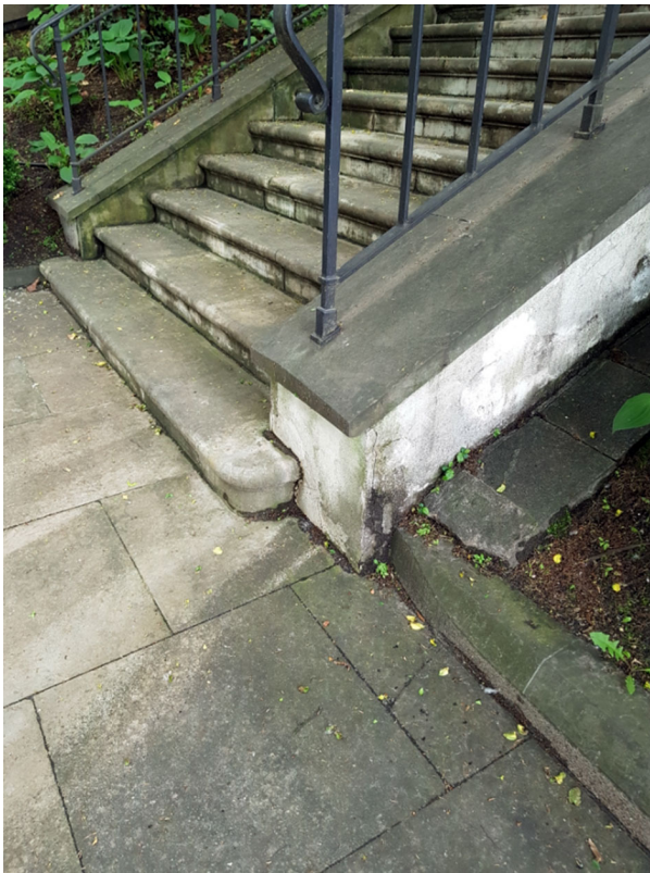
Ryc. 1, 2. Schody boczne, południowe. Stan przed remontem (1) i w czasie remontu, po ułożeniu nowych stopni (2)
