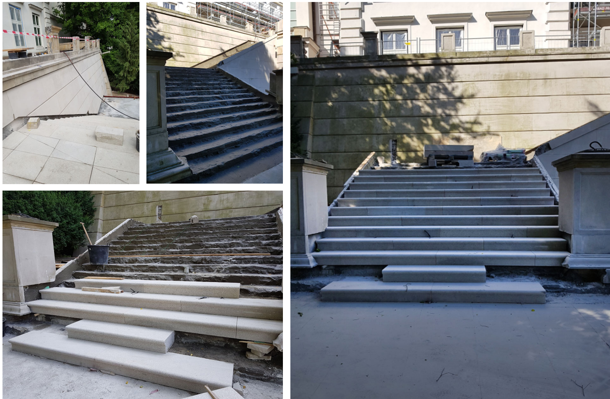
Ryc. 6, 7, 8, 9. Południowa część schodów głównych, łączących taras górny i dolny, w różnych fazach remontu, po rozbiórce uszkodzonych elementów i w czasie układania nowych stopni
