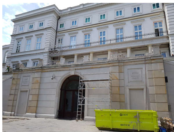
Ryc. 10, 11, 12. Ogrodowa elewacja Pałacu Prezydenckiego: w czasie remontu balkonu I piętra i po zasadniczych pracach remontowych, w okresie czyszczenia muru oporowego tarasu górnego Fig. 10, 11, 12. Garden elevation of the Presidential Palace: during the renovation of the 1 st floor balcony and after the basic renovation work, while the resistance wall of the upper terrace was being cleaned
