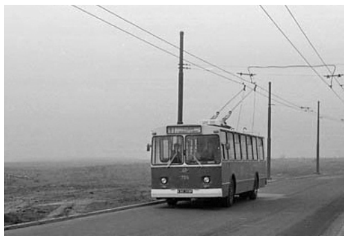
Fot. 1. Testowanie nowo wybudowanej sieci trolejbusowej Źródło: www.ltek.strefa.pl (fot. W. Turzański)
