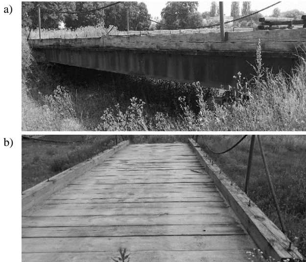
Rys. 3. Widok przęsła mostu niskowodnego z pojedynczym drewnianym pokładem poprzecznym (Żurawik, 2015): a) z boku, b) od przodu
