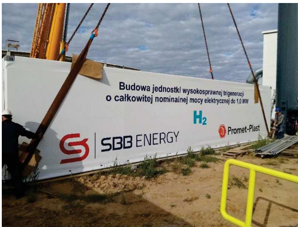
Rys. 2. Prace na placu budowy na terenie Promet-Plast w Gaju Oławskim (opracowanie własne)
