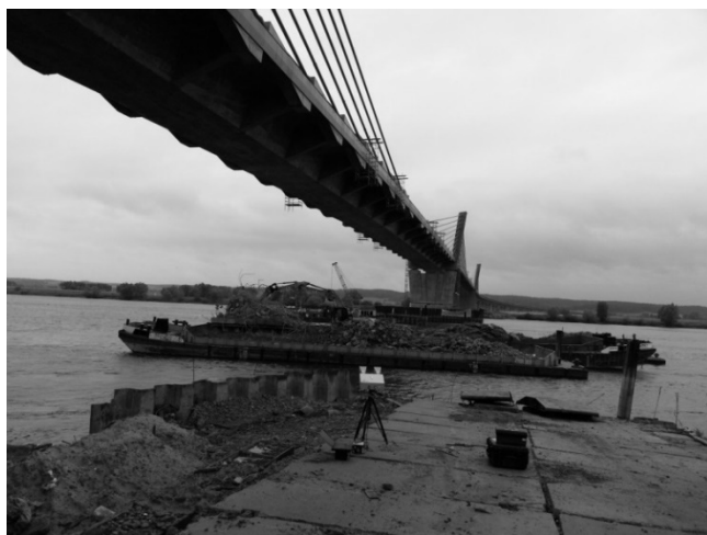
Fig. 7. Acceptance tests of one of the longest bridge spans in Poland Rys. 7. Pomiary odbiorcze jednego z najdłuższych przęseł mostowych w Polsce
