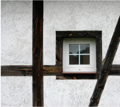
Fig. 5. Wattle and daub wall fragment, Swółowo. Source: Fot. K. Słuchocka
