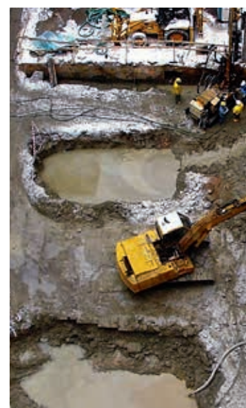
Ryc. 11–13. Metody gromadzenia i usuwania urobku: (po lewej) w betonowozach, (w środku) w kontenerach, (po prawej) w dołach na urobek
