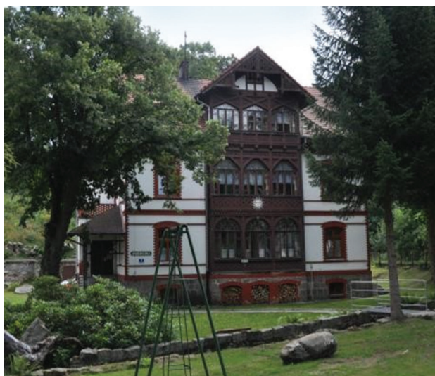
Il. 6. Szklarska Poręba, dom przy ul. Turystycznej 7, elewacja północna (fot. A. Wojtas-Harań, 2018)
