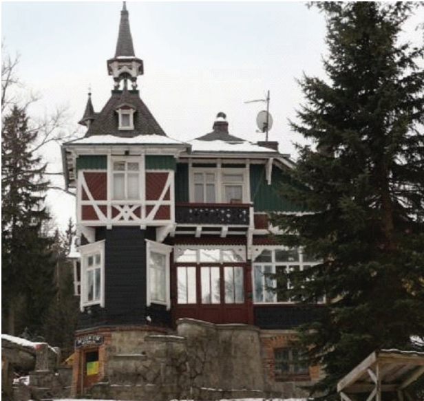
Il. 2. Szklarska Poręba, dom przy ul. Kilińskiego 20, elewacja północna (fot. A. Wojtas-Harań, 2018)
