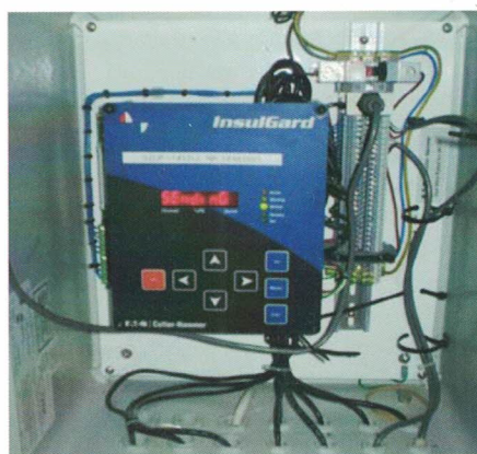
Rys. 27. Skrzynka zewnętrzna układu InsulGard do pomiarów wzn firmy CUTLER-HAMMER [9]
